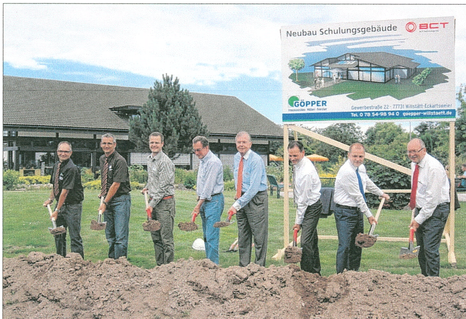
Erster Spatenstich für das neue Schulungsgebäude der BCT, von links: Manfred Göpper und Marcus Müller (beide Firma Göpper), Bürgermeister Marco Steffens, Albrecht Neumann und Horst Weitzmann (beide Aufsichtsrat BCT AG), Jürgen Hillemann und Klaus Erdrich (beide Vorstand BCT AG) sowie Wolfgang Doll, Prokurist BCT AG.
