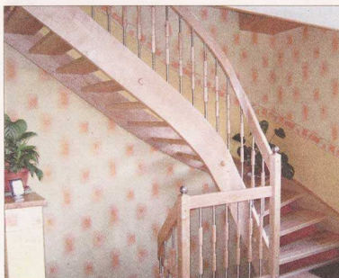
Stockwerkstreppe in Can. Ahorn mit Edelstahl kombiniert.
